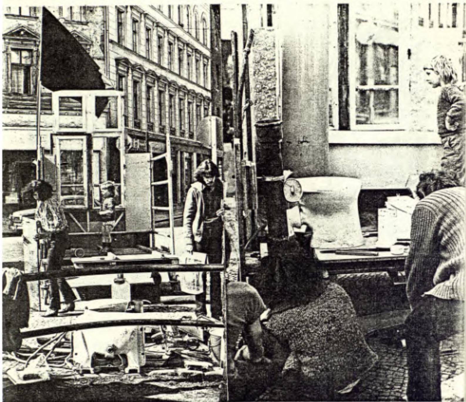
BAU EINES BADEZIMMERS AUF DEN DRAUSEITEN
